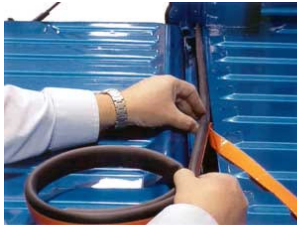
Resim 2.39: Sızdırmazlık sağlayan kapı fitillerinin yenilenmesi
