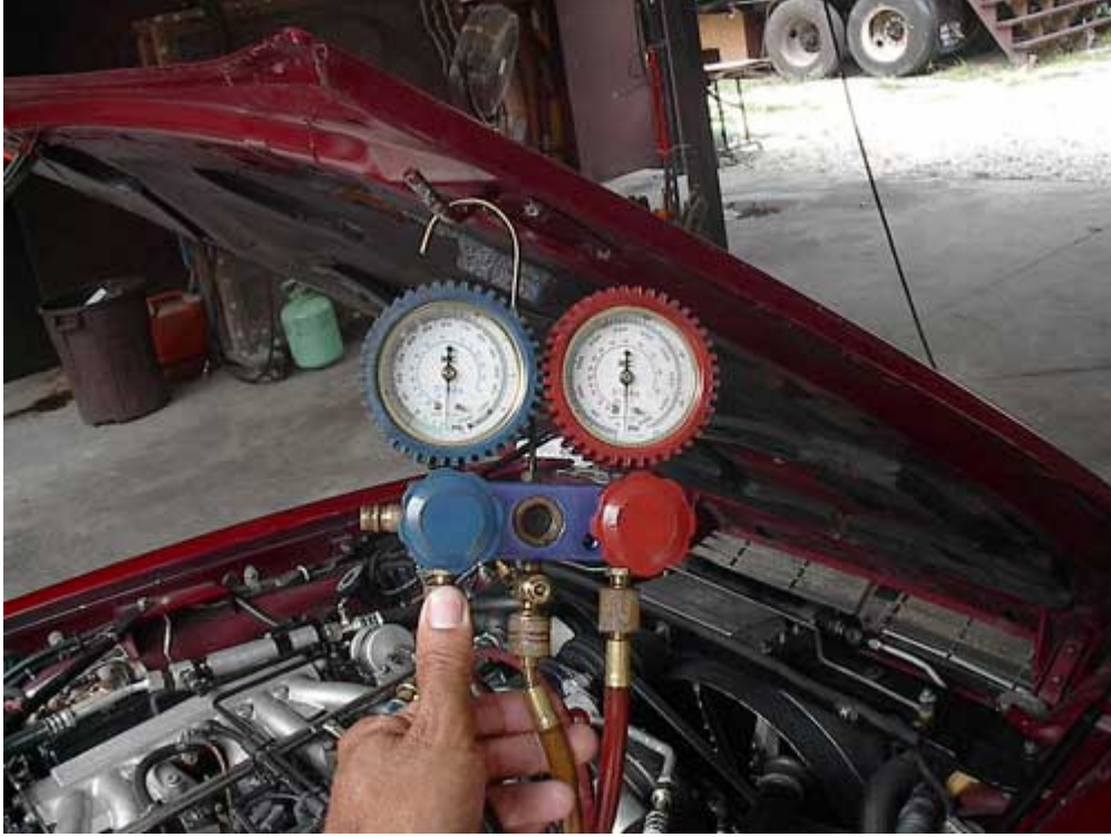
Resim 1.5: Klima soğutma sisteminin basınç değerlerinin ölçülmesi
